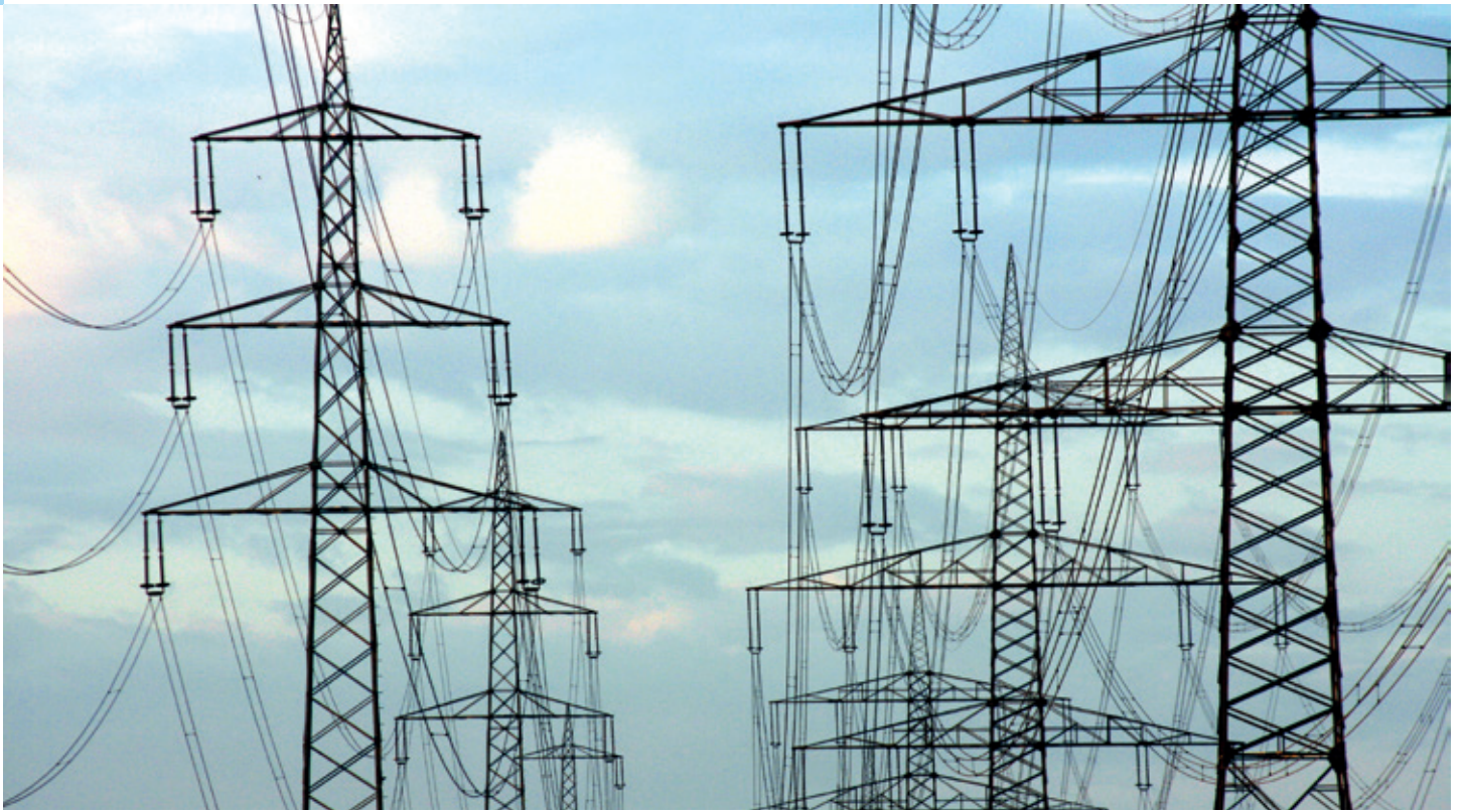
Im Falle der EU-Rechtswidrigkeit könnte die Netzentgeltbefreiung für stromintensive Betriebe entfallen.
